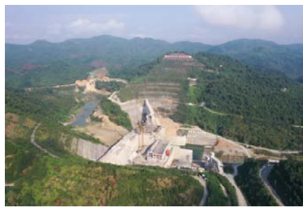
图 1 边坡工程现场图
